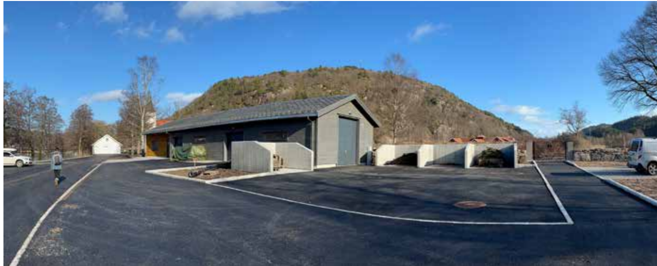
På bildet over ser man det nye bygget med oppbevaringsbaser og kjøreport. Lengst til høyre ser man veien og porten inn til området som skal bli ny gravplass. I bakgrunnen til venstre skimter man kirken og det gamle driftsbygget og toalettanlegget.
