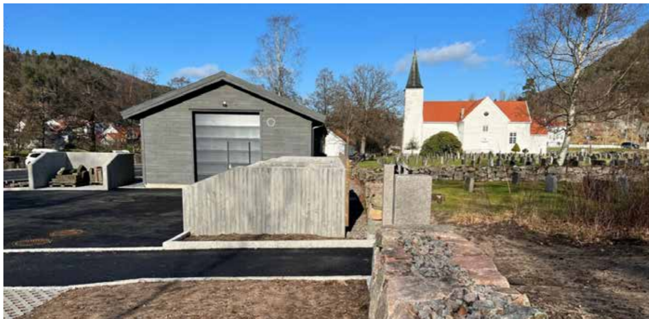
I forgrunnen ser man ny steinmur og et område som skal beplantes. Helt til høyre, litt av det som skal bli ny gravplass. Dette området blir imellom den gamle kirkegården og E39. I området skal det gjøres arkeologiske utgravinger, etter pålegg fra Riksantikvaren. Lindesnes kommune har satt av midler til utgraving i 2023 og videre opparbeidelse av ny gravplass i 2025.
